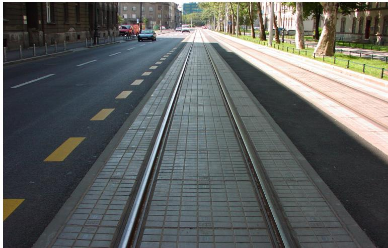
Sistem učvršćenja kolosijeka DEPP u uporabi je od 1997. godine kao standardno rješenje za kolosijeke tramvaja i lakih željeznica u Hrvatskoj. Do sada je, bez ikakvih poteškoća i zamjerki, ugrađeno preko 80.000 komada pričvrsnih mesta tipa DEPP na tramvajskim kolosijecima u Zagrebu i Osijeku.
